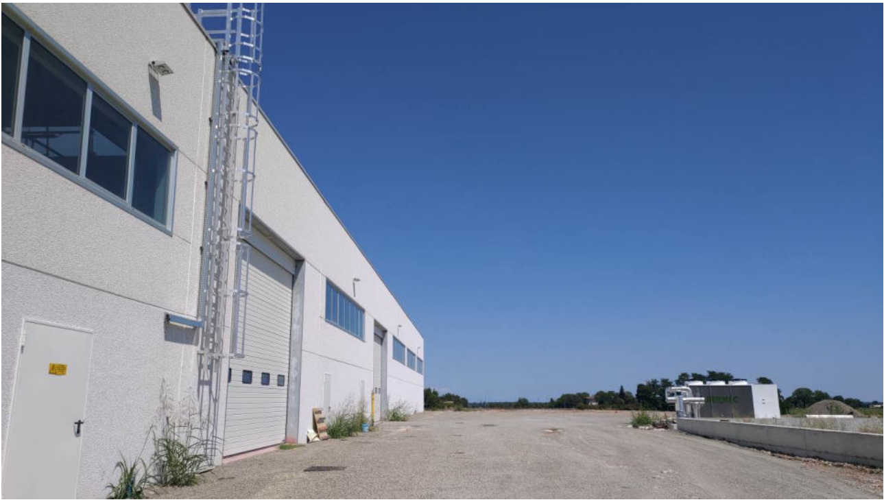
13. Vista del retro del capannone, dove verrà collegato l'ampliamento in progetto
