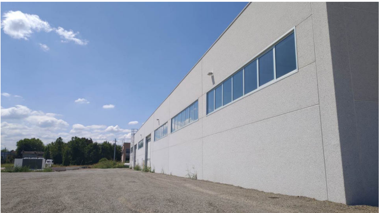
14. Vista della porzione di capannone alla quale sarà collegato l'ampliamento
