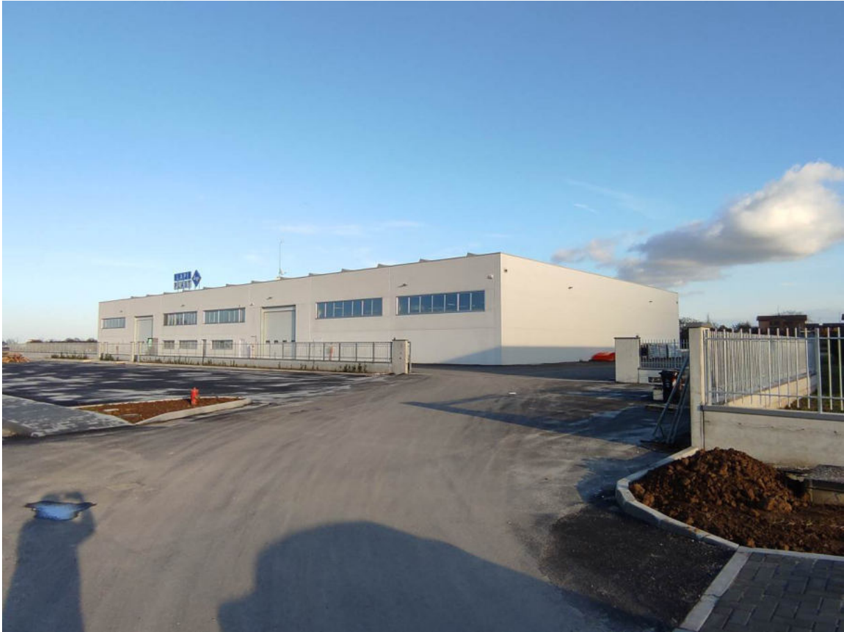
3. Immagine del capannone esistente
