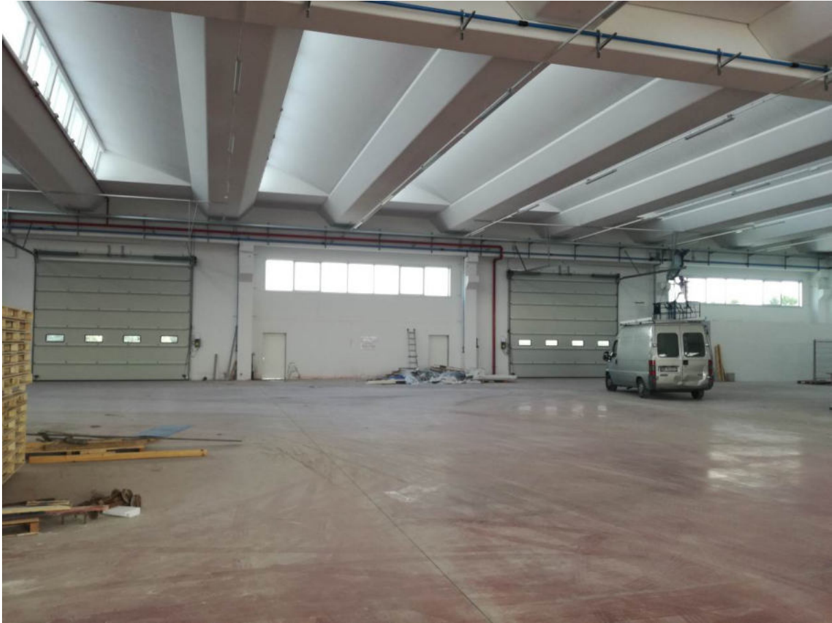
15. Vista dell'interno del capannone esistente con struttura prefabbrica.
